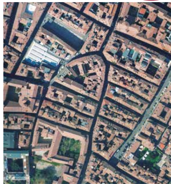
Area fra via Canalino e via Mondatora.
