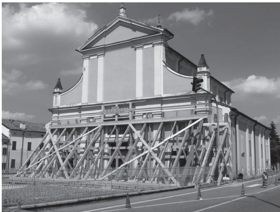
1. Brugneto, Chiesa parrocchiale della Santissima Annunziata, facciata
